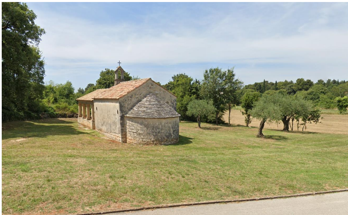
Slika 6: Crkvice Bezgrešnog začeca BDM (Concetta). Prostor oko apside te između apside i ulice nalazi se na k.č. 9280/9 k.o. Rovinj i planira se njegovo priključenje crkvi. Foto: Google, 2024.
