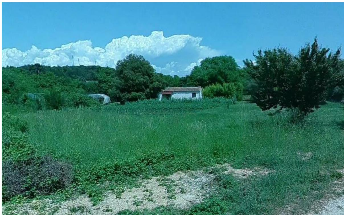
Slika 8: Poljoprivredna građevina i plastenik na k.č. 9299/1 k.o. Rovinj; Foto: Google, 2024.
